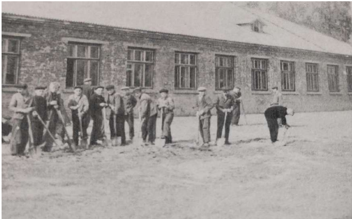
Будівництво лівого та правого крила школи
