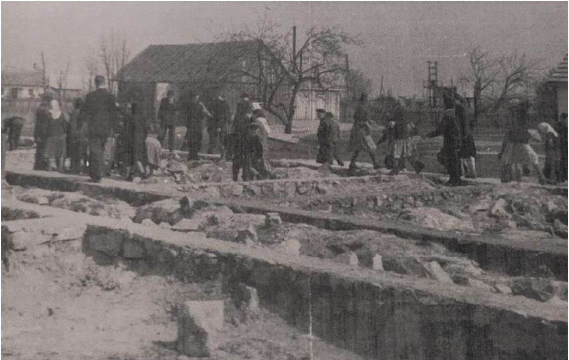
Будівництво нового корпусу школи
