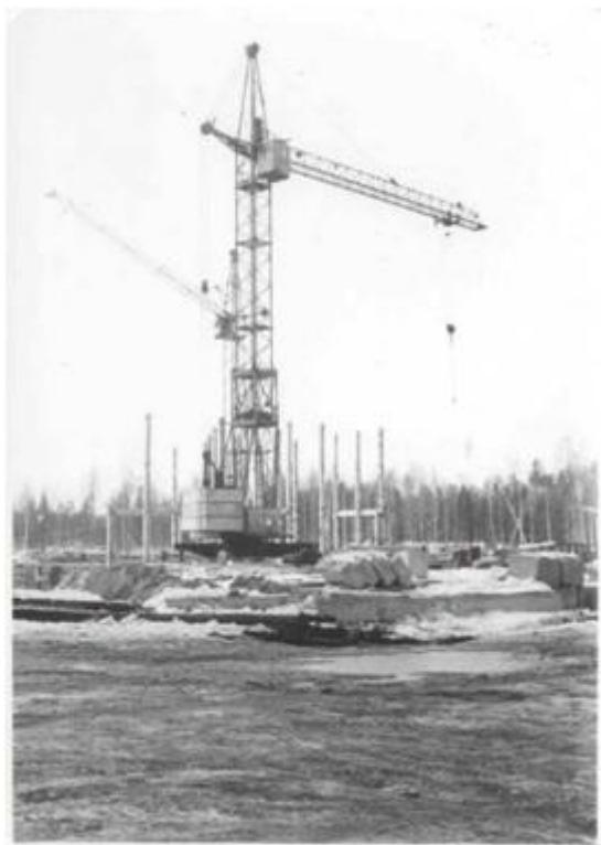
Початок будівництва Славутицької ЗОШ № 3
