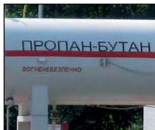
Рис. 21. Емкость с пропан- бутановой смесью на авто- заправочной станции
