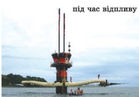
Мал. 143. Припливна електростанція
