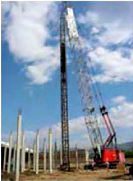
Рис. 222. Завивання цилі під фундамент за допомогою будівельної машини — коцера
