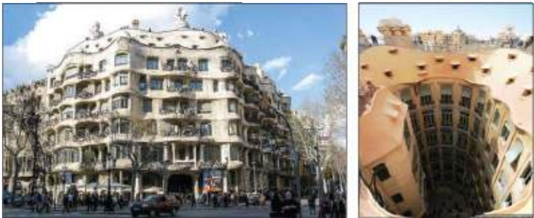
Будинок Міла. Сіasad, Внутрішній двір
