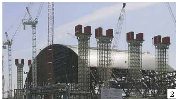
Мал. 282. 1. Катастрофа на Чорнобильській атомній електростанції 1986 р. 2. Спорудження оновленого саркофага над зруйнованим четвертим блоком 2016 р.
