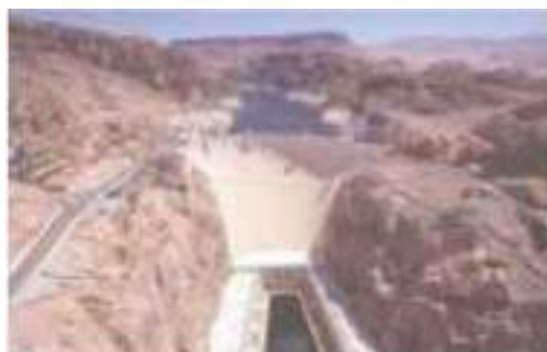
Мал. 85. Гідроелектростанція на річці Колорадо
