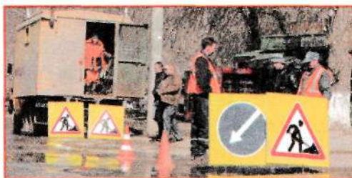
Мал. 1.10. Знак проведення ремонтних робіт
