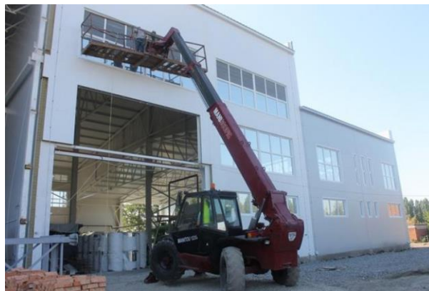
Рис.2. Будівництво надсучасної теплоелектростанції на біомасі у м. Кам'янець-Подільський
